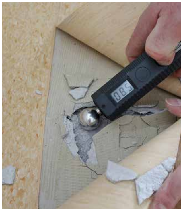
Vlhko v podkladu a neodbroušený šlem, na to nebyly peníze v rozpočtu.
