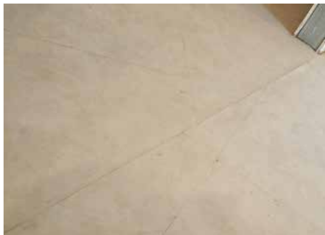
Nalepená vinylová podlahovina, přechod z jedné místnosti do druhé – nějak se to nesešlo. Levnější nabídka.
