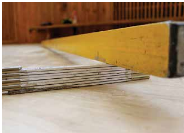
Levnější varianta pokládky bez nivelace stávajícího podkladu. Nejlevnější nabídka.
